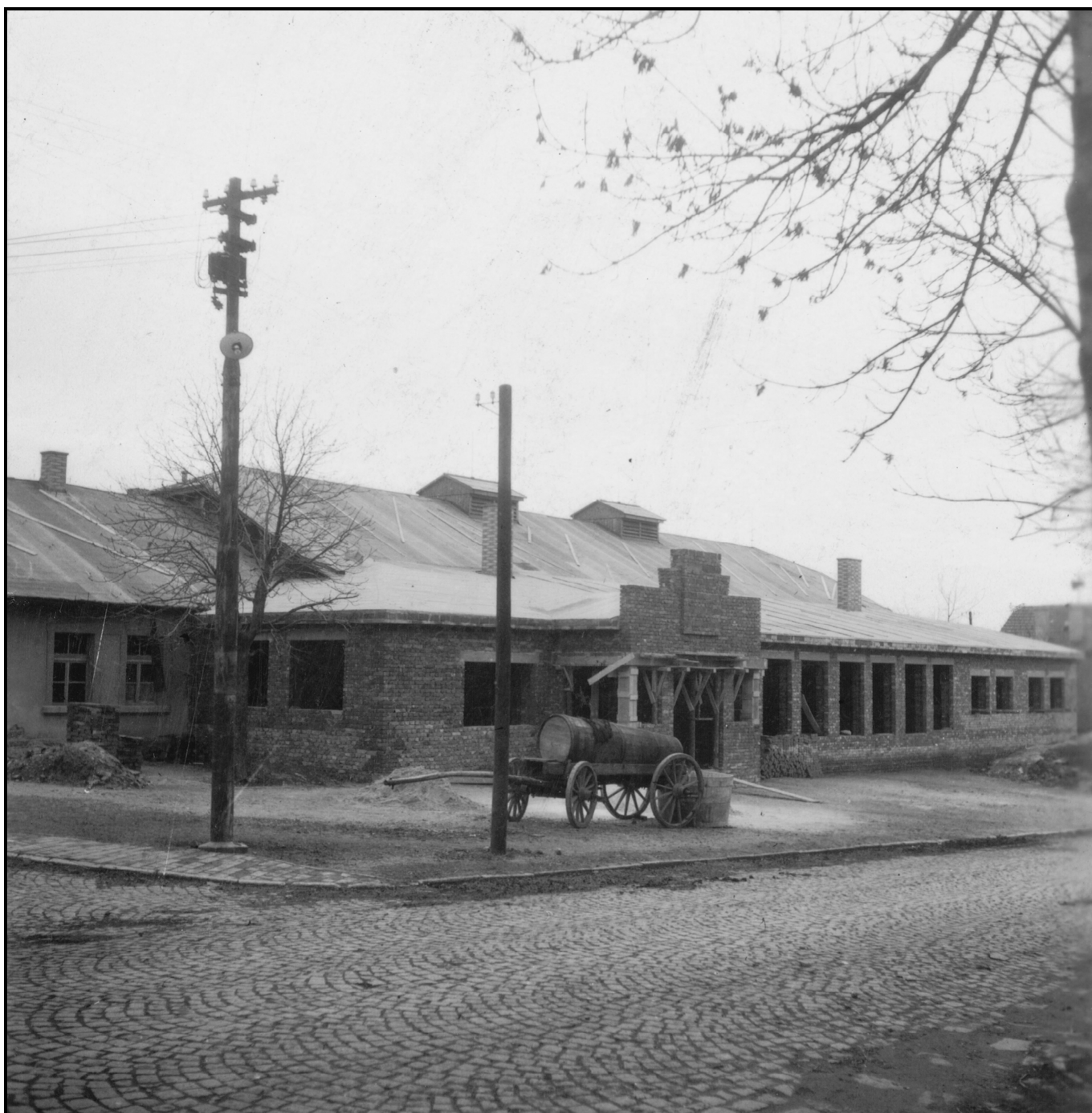
Přestavba sokolovny dokončená v roce 1952.
