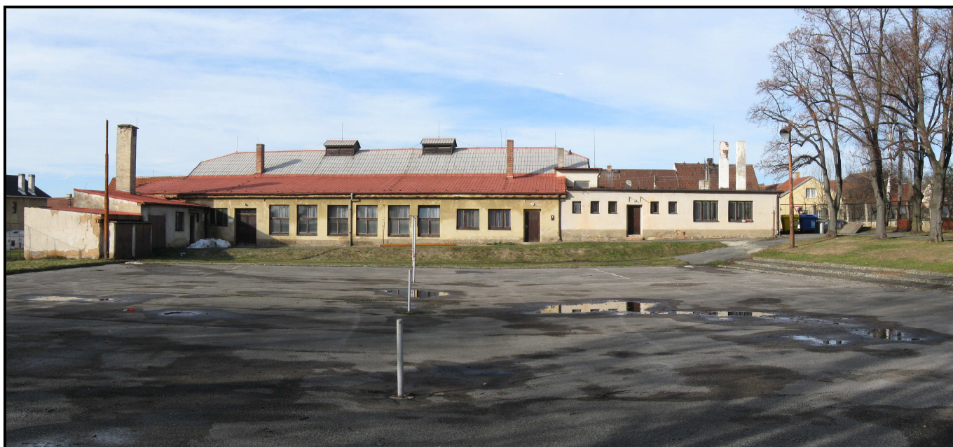
Sokolovna z letního cvičiště zachycená vždy před přestavbami – v roce 1968 a v roce 2011.
