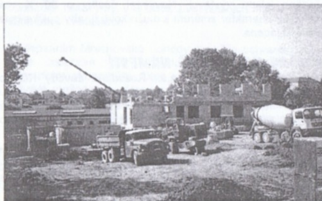
Snímek z prvních srpnových dnů ukazuje stav prací na výstavbě Domova důchodců v těsném sousedství DPS.
