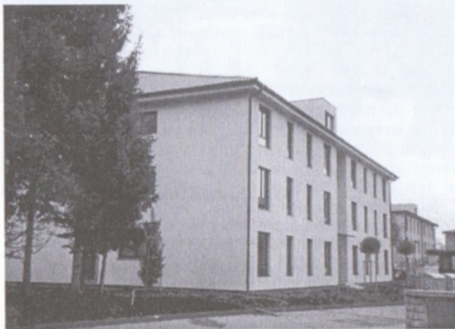
Sedmý v pořadí, právě dokončený bytový dům v Jarní ulici zvaný „E“, zvýšil počet malometrážních bytů na 198.
