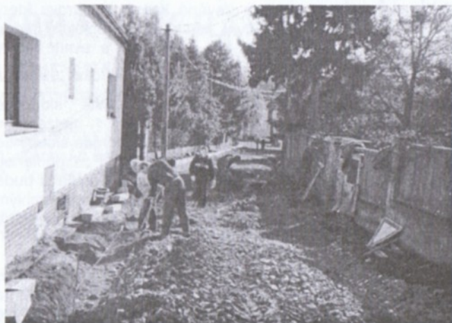
Rekonstrukce povrchu ulice Pionýrů – foto 22.10.2001
