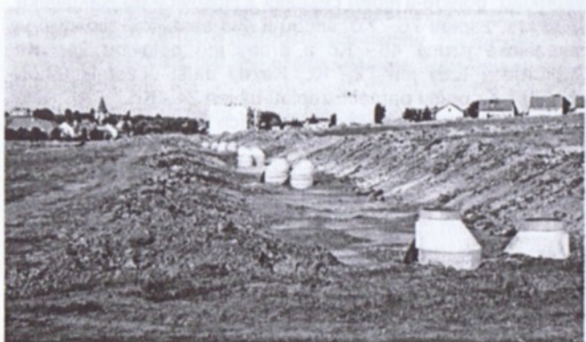
Staveniště v polovině srpna 2003 Foto A. Křížková
