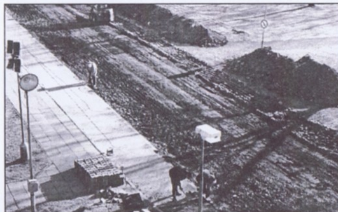
Rekonstrukce komunikace – foto A. Křížková
