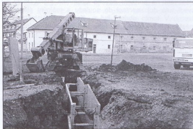
Firma Risl, s.r.o.pokračuje v rekonstrukci splaškové kanalizace na Husově náměstí - foto 18.1.2005 A. Křížková
