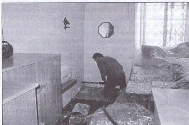
Prostup více jak jeden metr širokými zámeckými kamennými zdmi je velmi obtížný
