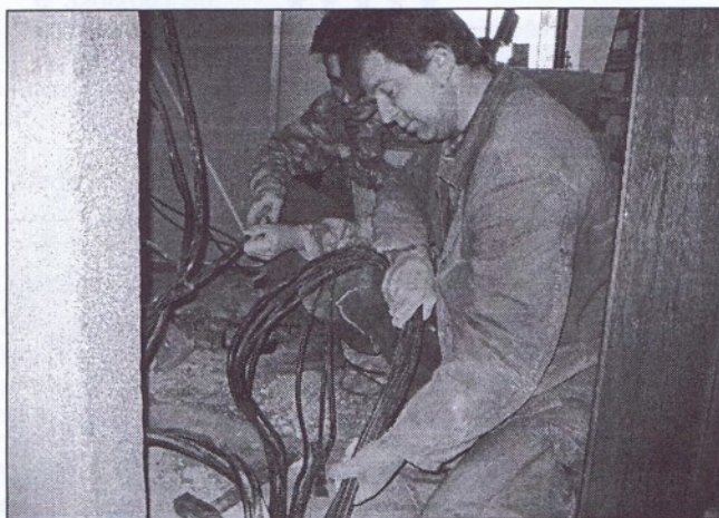
Pokračuje rekonstrukce elektroinstalace v budově radnice - kanceláře účtámy v I. patře - 18.2.2005 Text Ing. Bohumír Machek, foto A. Křížková
