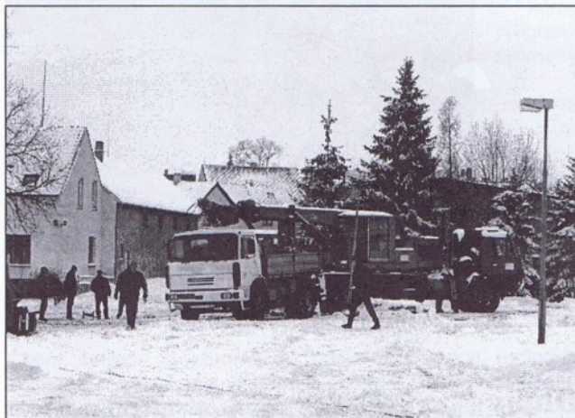
Firma RISL, s.r.o. pokračuje v rekonstrukci splaškové kanalizace na Husově náměstí - 23.2.2005
