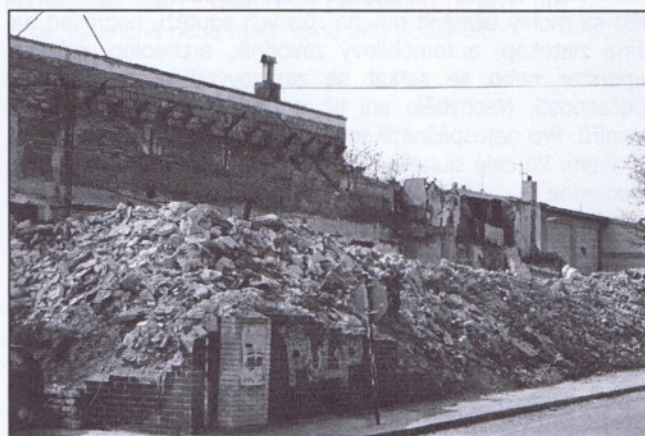
Pohled z karlovarské silnice - foto 5.4.2005
