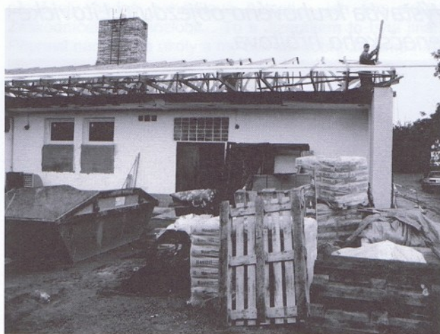
Foto z průběhu stavby červenec, srpen 2006 - M.Křížková
