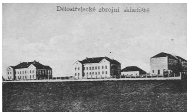
Vojenský areál v Jiráskově ulici postavený v roce 1912
