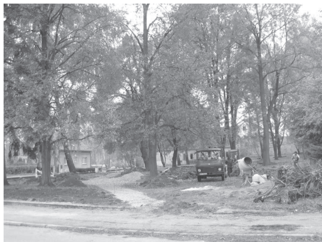
Park TGM v Litovicích - stav k 23.10.2007
