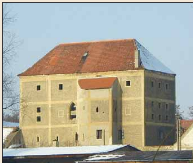
Kaple litovické tvrze se nachází ve 2. patře v jižním přístavku
