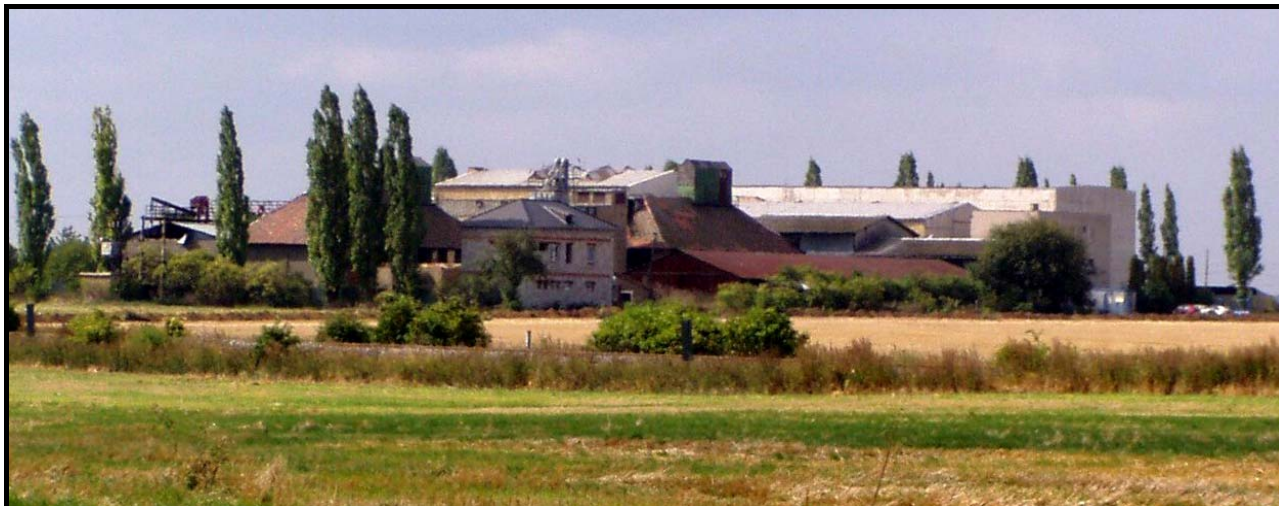
Na dálkovém pohledu na areál čistírny osiv ze 16. září 2004 jsou ještě vidět střechy bývalých císařských kůlen na obilí
