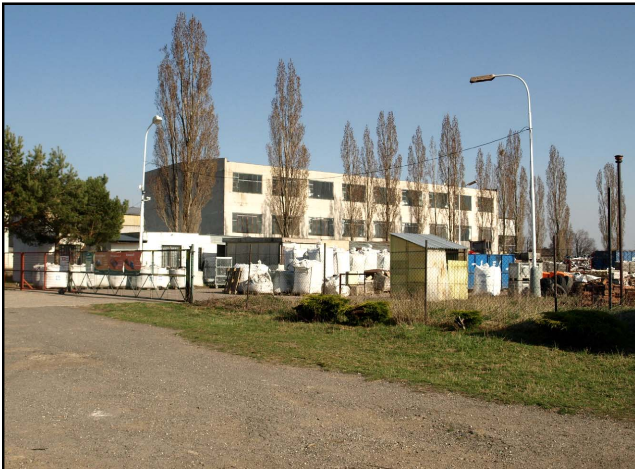
Areál střediska pro odpady T.O.P. Umwelt s. r. o. čp. 674 dne 8. dubna 2010. V pozadí budovy čistírny osiv. Foto Jindřich Lukášek
